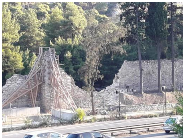
Εικόνα 4. Η θέση του επιταχυνσιογράφου (τρίγωνο) στον περίβολο του αρχαιολογικού χώρου σε σχέση με τη θέση κατάρρευσης του βορεινού περιμετρικού τείχους (άστρο), η εγκατάσταση του οργάνου και η κατάρρευση του τείχους λόγω του σεισμού.
